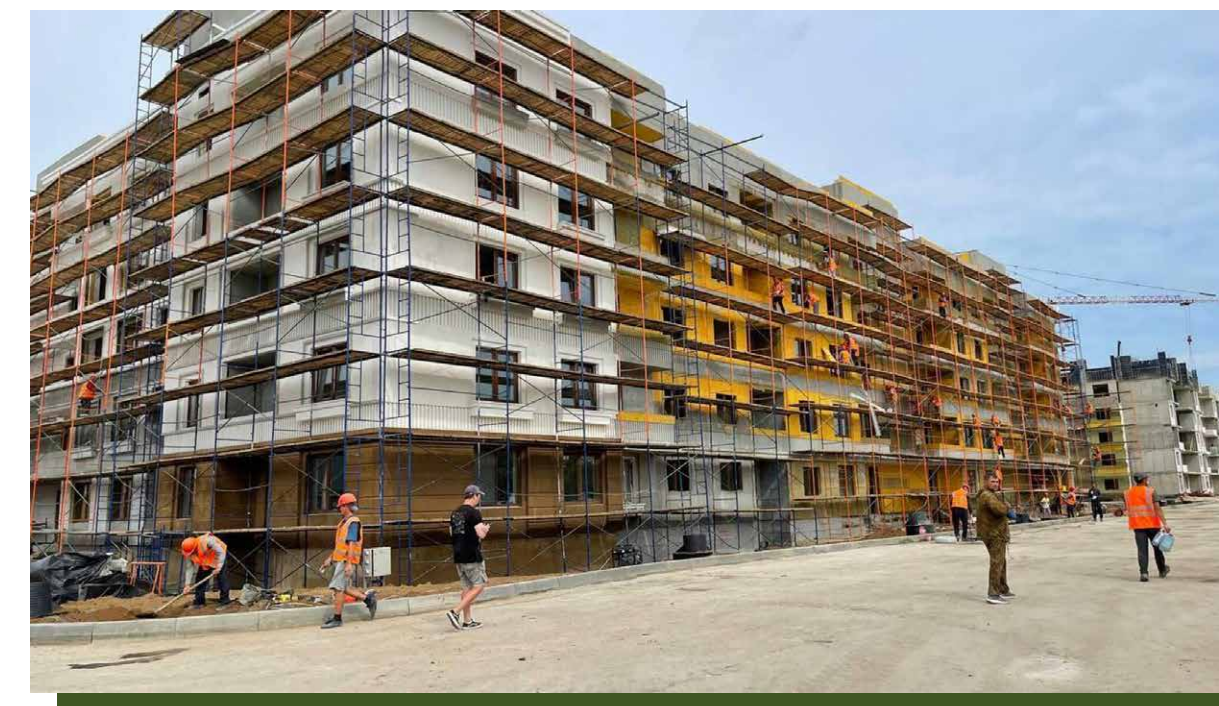
Работы по восстановлению города Мариуполя, разрушенного ВСУ. Август 2022 г.
